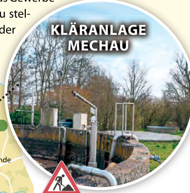
Die Kläranlage Mechau wird saniert.
