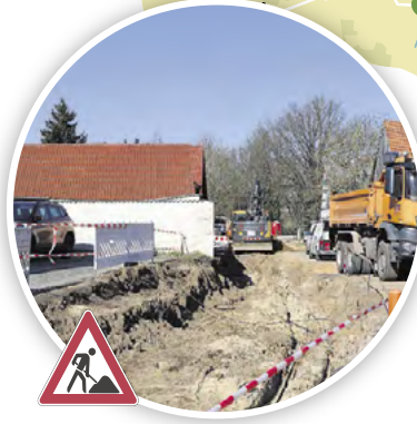
In Henningen werden 460 Meter Kanal neu gebaut.
