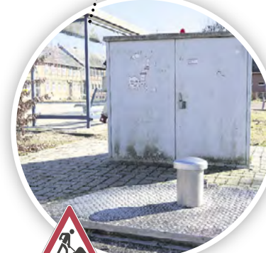
Das Hauptpumpwerk in Apenburg ist über 30 Jahre alt und wird ersetzt.
